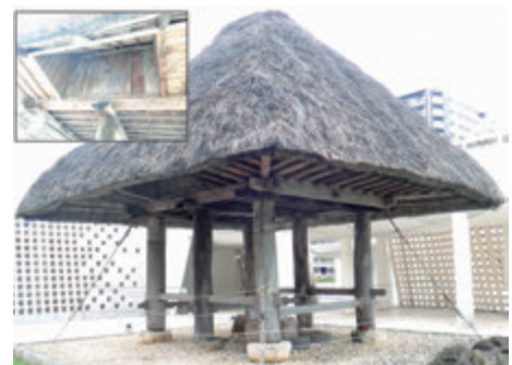
図11 沖永良部島(奄美諸島)の高倉(沖縄県立博物館に移築されたもの)。左上は庫内への入り口。脚柱は礎石の上に立っており、鉄板のネズミ返しは付いていない。
