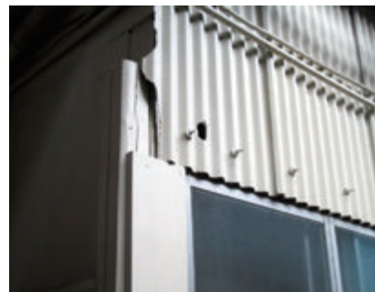
③包装場(箱詰め)の壁
